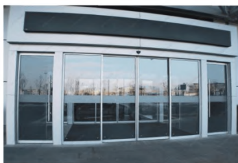
Рисунок 6.1.8 – Оборудование входов вращающимися и раздвижными дверями
