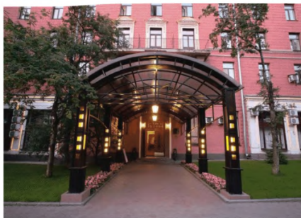
Рисунок 5.18 – Слева – козырек на металлических подвесах, справа – козырек на опорах
