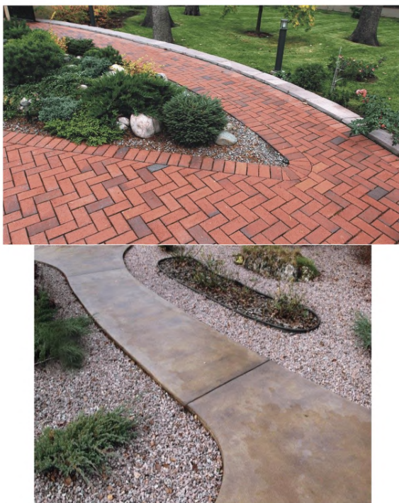
Рисунок 5.10 – Покрытия для дорожек. Слева покрытие, которое неудобно использовать МГН
